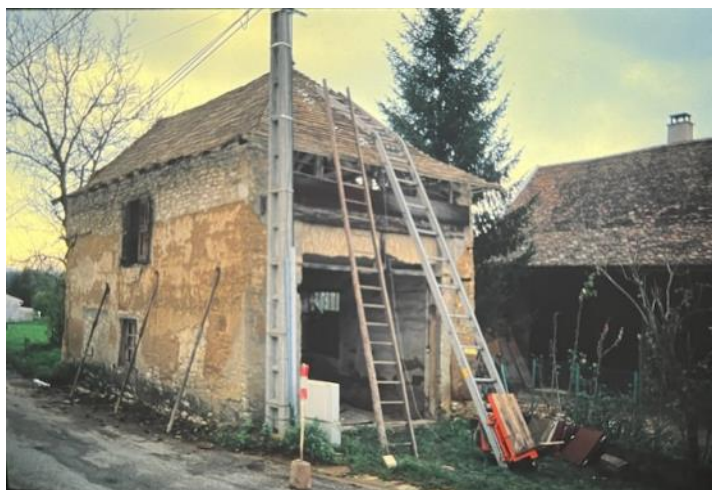
Bâtiment du congélateur de Vézeronce lors de sa démolition
